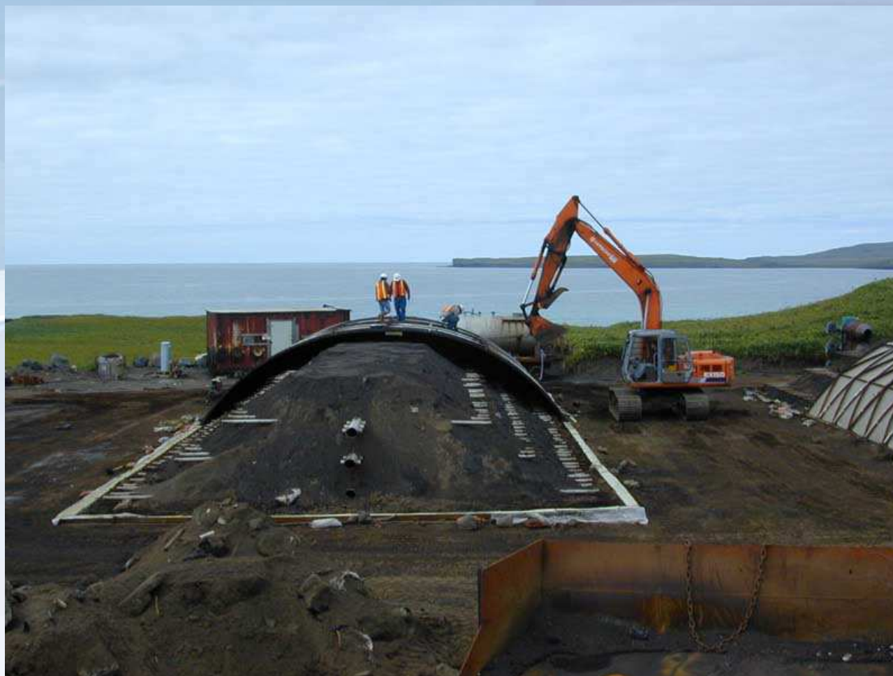
Restauración de suelo mediante conducción térmica, Isla de St. Paul
