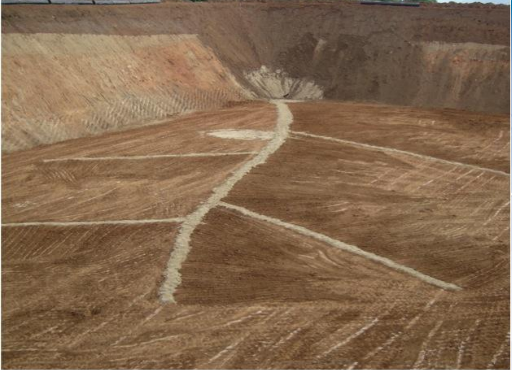
Instalación del drenaje
