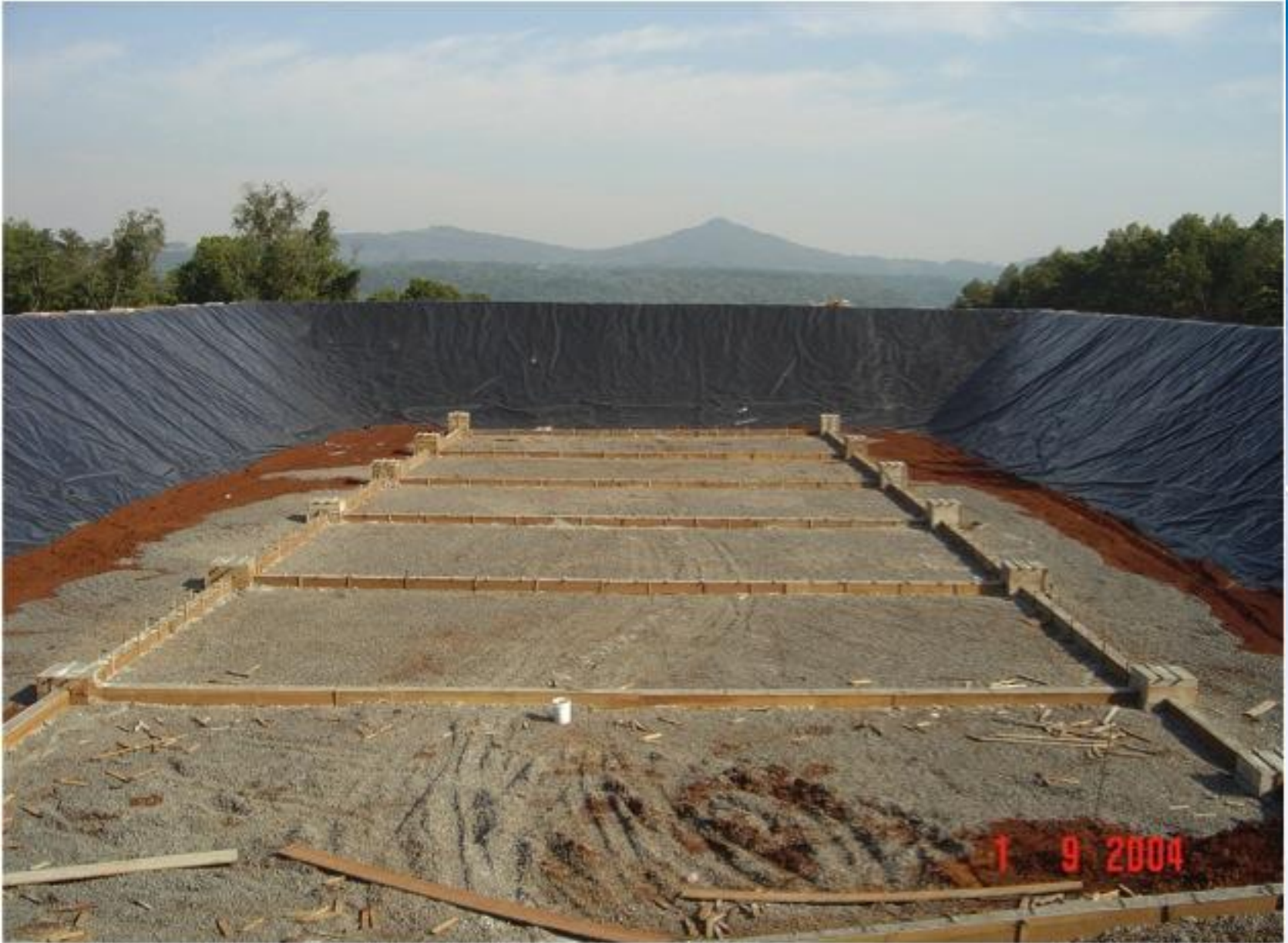
Bases estructura metálica del techo
